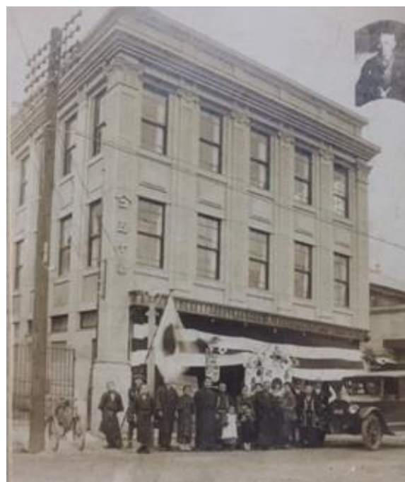
五十嵐商店 昭和3年 増改築工事竣工時
