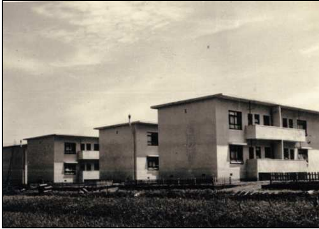
（北加瀬第 1 竣工写真）
