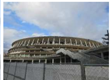
写真：新国立競技場
